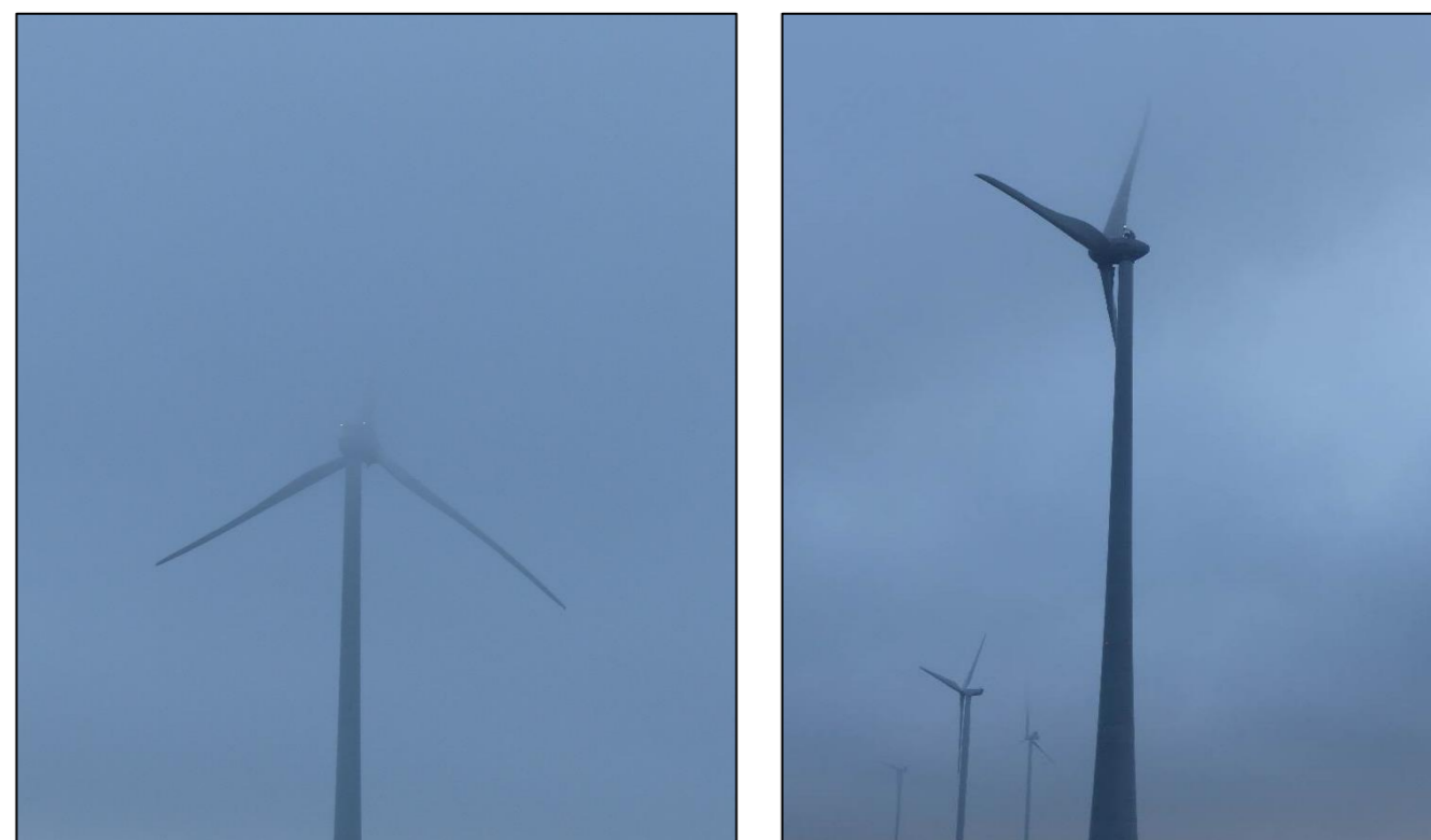
Photographie 40 : Exemple de situation à risque : brouillard en hauteur masquant tout ou partie des pales.
